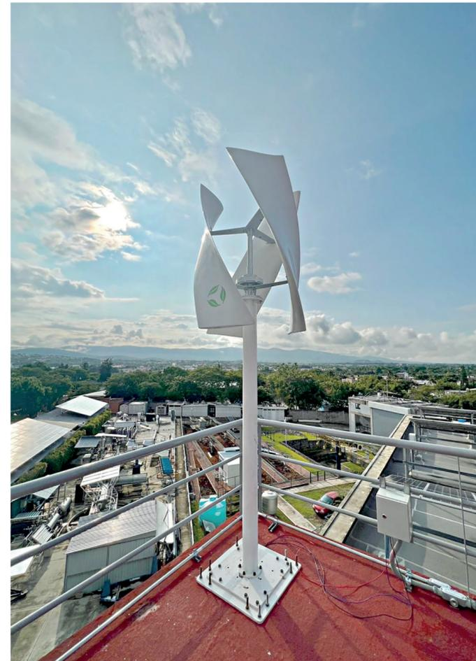
FIGURA 3- AEROGENERADOR de eje vertical instalado en el Instituto de Energías Renovables. Tiene una potencia nominal de 600W y un largo de pala de 0.8 m – (Foto propia).
