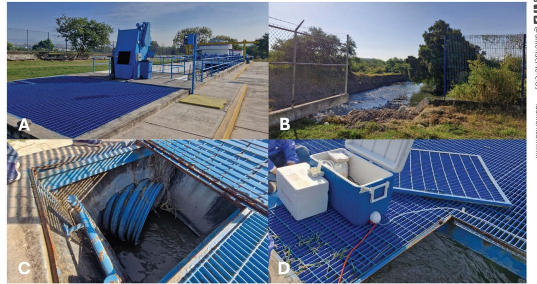
**FIGURA 3. TOMA** de muestra en la planta de tratamiento “El Rayo” en Temixco. A, Vista general de la planta; B, Río Apatlaco en su paso por Temixco; C, Cisterna de entrada de la planta; D, Primeras pruebas del dispositivo de muestreo.
