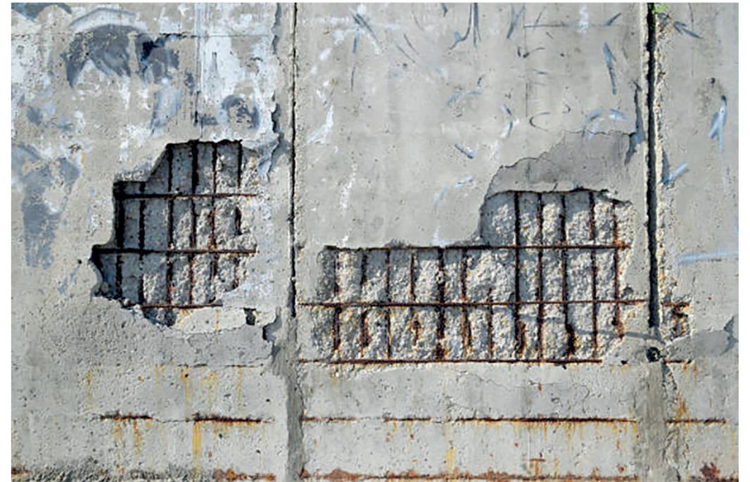
FIGURA 3. MURO deteriorado sin cubierta de concreto en donde se observa el acero expuesto a corrosión atmosférica. [HTTPS://WWW.ISTOCKPHOTO.COM/ES/FOTO/DESTRUYENDO-EL-MURO-DE-HORMIGON-C3%B3N-ARMADO-CA-C3%ADDA-DE-YESO-GM1017692268-273651218](https://www.istockphoto.com/es/foto/DESTRUYENDO-EL-MURO-DE-HORMIGON-C3%B3N-ARMADO-CA-C3%ADDA-DE-YESO-GM1017692268-273651218)
