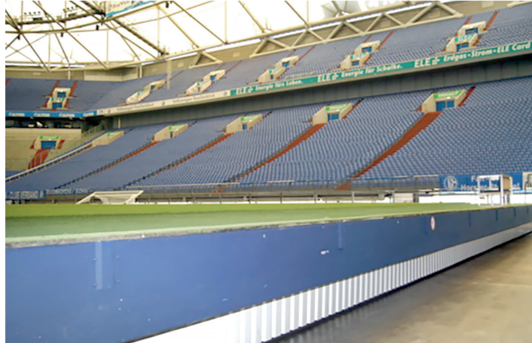
LA TINA DE tierra con el césped en la Arena de Schalke. La construcción puede rodar sobre baleros para ser sacada del estadio y recibir luz natural.
