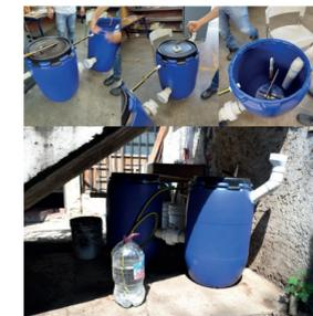
FIGURA 4. CONSTRUCCIÓN del biodigestor por los ingenieros y técnicos del taller del IER-UNAM, la imagen de abajo corresponde a la instalación del biodigestor en el refugio "4 Patitas".
