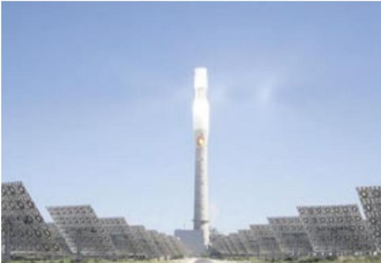
Figura 1. Tecnología de torre central para generación de potencia eléctrica (planta Gemasolar, en Andalucía, España).
